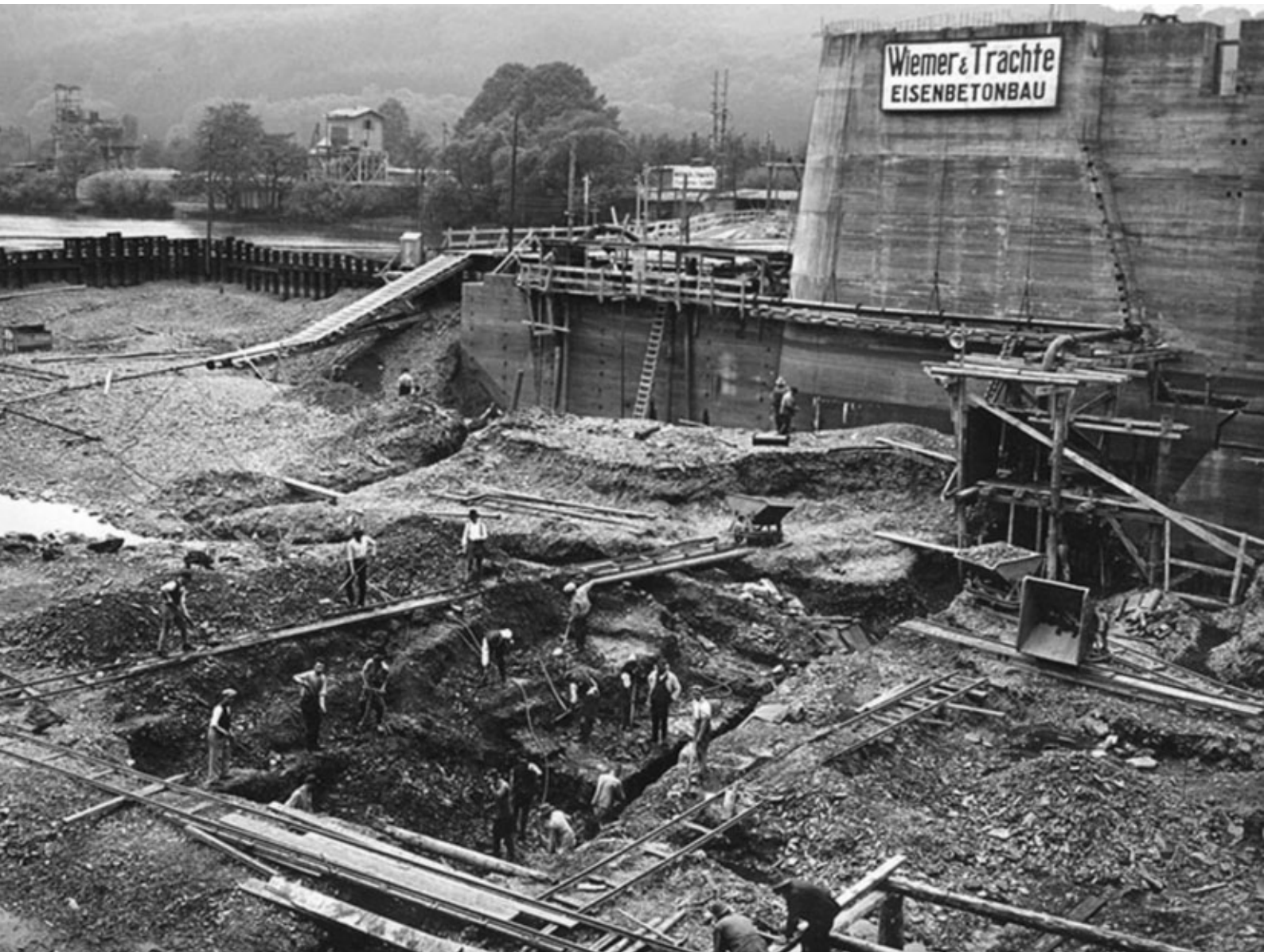
Foto: Stadt Essen. Arbeiten am Stauwehr.
